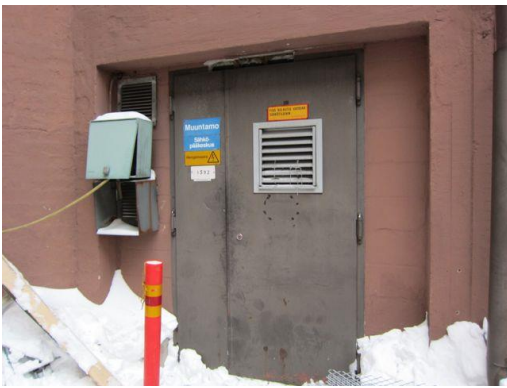
Kuva 1. Sähköpääkeskukseen johtava ovi
